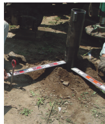
⑥ 施工完了(杭頭スレ確認)
