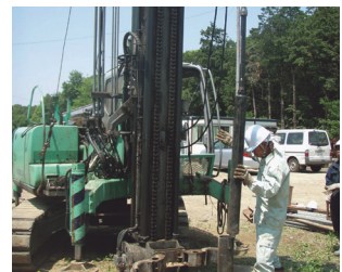
⊕α(1) 杭先端部モンケン落下
