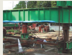
▲鉛直載荷試験 拡翼効果により、大きな支持力を得ることができます。
