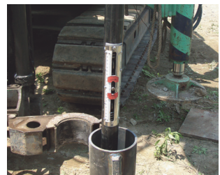
⊕α(2) スライドウェイト計測(支持地盤の確認)
